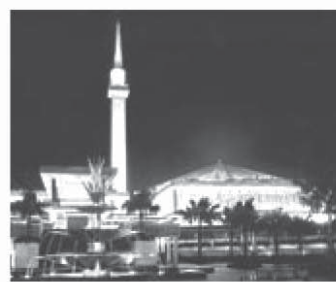
Urban Lighting Masjid Negara
