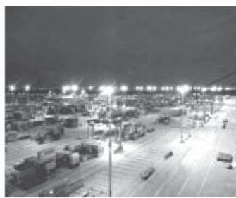
Flood Lighting Pelabuhan Tanjung Pelepas
